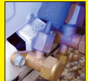
Die Stelle wird anschließend mit der Leuchte nachkontrolliert. Kein Leuchten bedeutet, dass alle Lecks repariert wurden.
