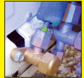
Jedes Leck leuchtet in einem stark fluoreszierenden Gelb/Grün-Ton, ein Nachweis für die genaue Stelle jedes einzelnen Lecks.
