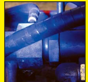
Die Stelle wird anschließend mit der Leuchte nachkontrolliert. Kein Leuchten bedeutet, dass alle Lecks repariert wurden.
